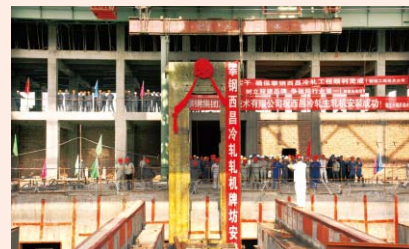
攀钢西昌冷轧机牌坊安装成功
