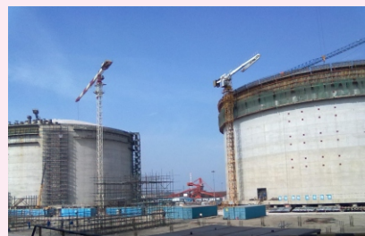
鞍钢集团生产的钢板应用于中石油液化天然气储罐项目
